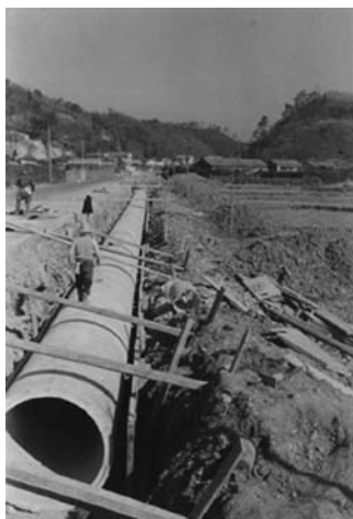
合流下水道の敷設（1960） 資料提供：横須賀市上下水道局
